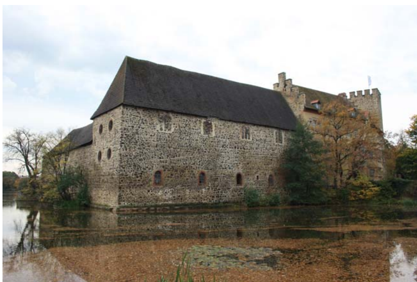
Abb. 4: Im Umfeld des Wasserschlosses Flechtingen leben Balea perversa und Vertigo pusilla an verschiedenen Stellen des Mauerwerks (Foto: U. BÖSSNECK).
